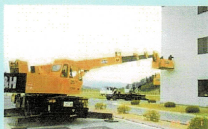
工場外壁シーリング
