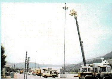
照明灯配線工事
