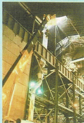
工場建屋内補強工事
